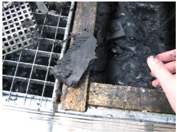
Boues de peinture compactes et sèches d'un séparateur A-25
